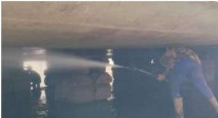
Gambar 2 Penyemprotan Water Jet
