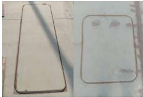
Gambar 3. 2 *Insert Plate* belum dilas
