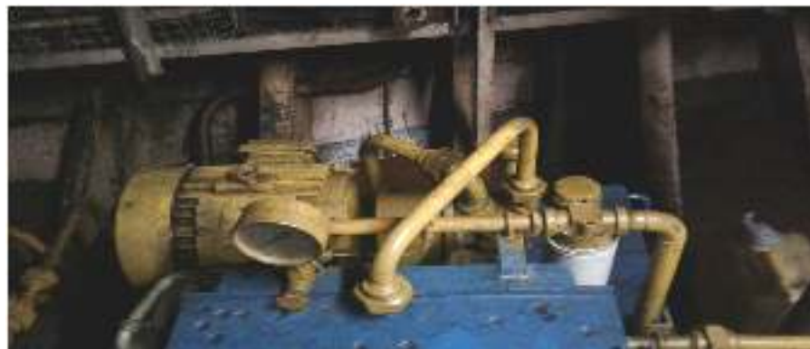
Gambar 3 Pompa Hidrolik
