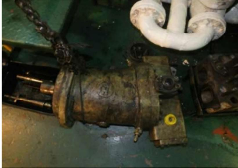
Gambar 2.4 Pompa *Hydraulic*
