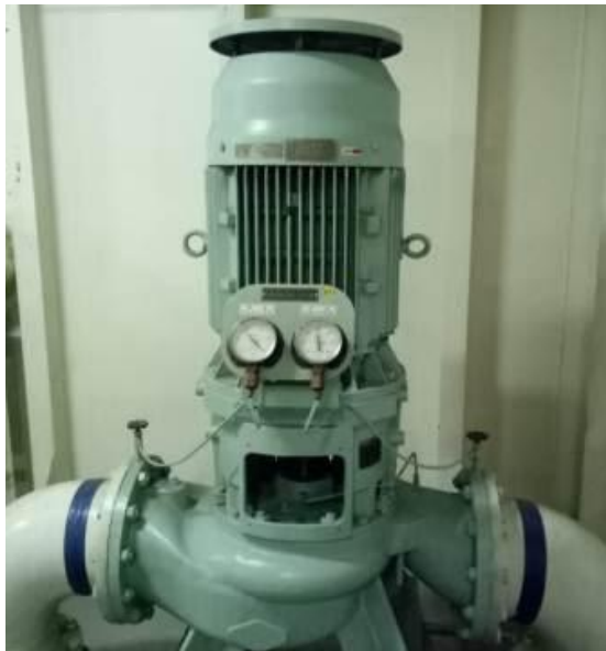
Gambar 2.1 Pompa Sentrifugal Sumber: Di KN. Prajapati
