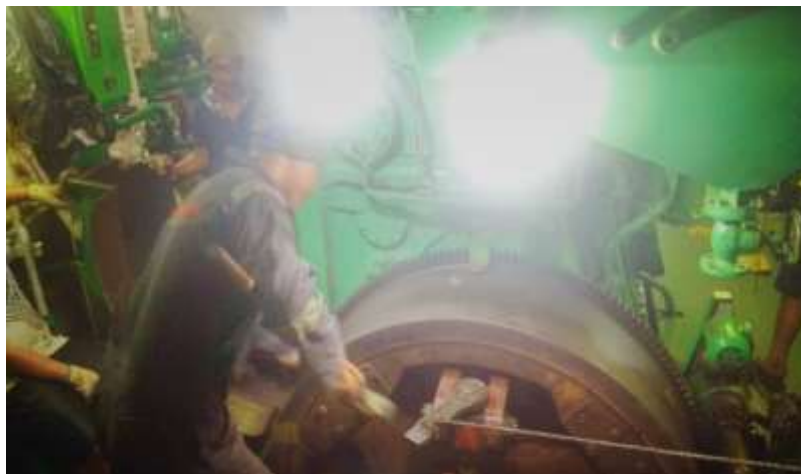
Gambar 7 Wheel Gear Sumber: Dokumentasi penulis
