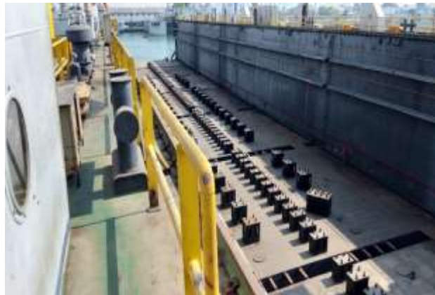
Gambar 1. Ponton Pada Dok Apung
