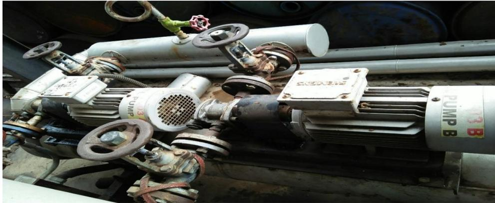
**Gambar 7** Pompa bahan bakar (*fuel pump*)
