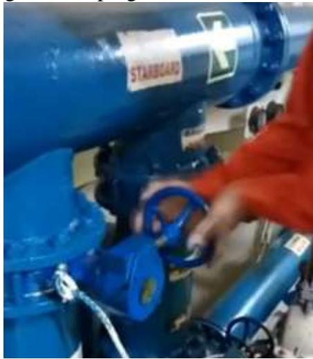
Gambar 14. Valve Air Laut
