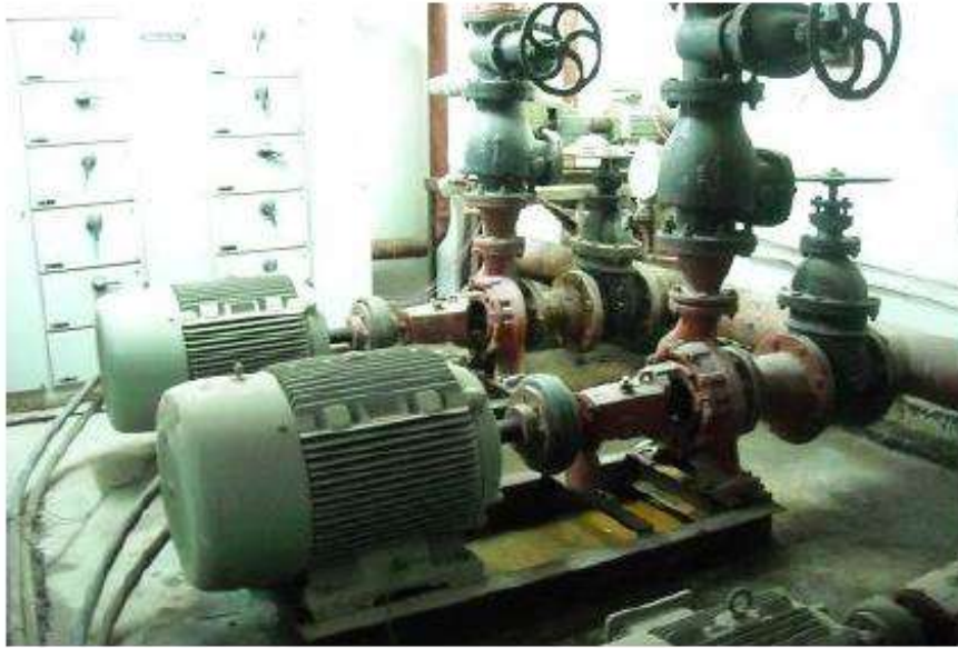
Gambar 14 motor listrik penggerak pompa pemadam kebakaran
