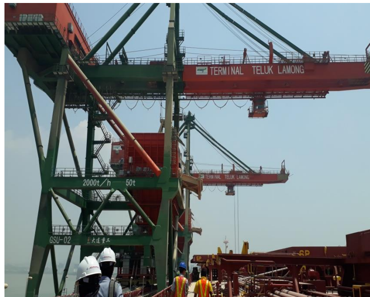
Gambar 1. GSU (Grab Ship Unloader) Sumber : Observasi PT. Esa Zona Ekspres
