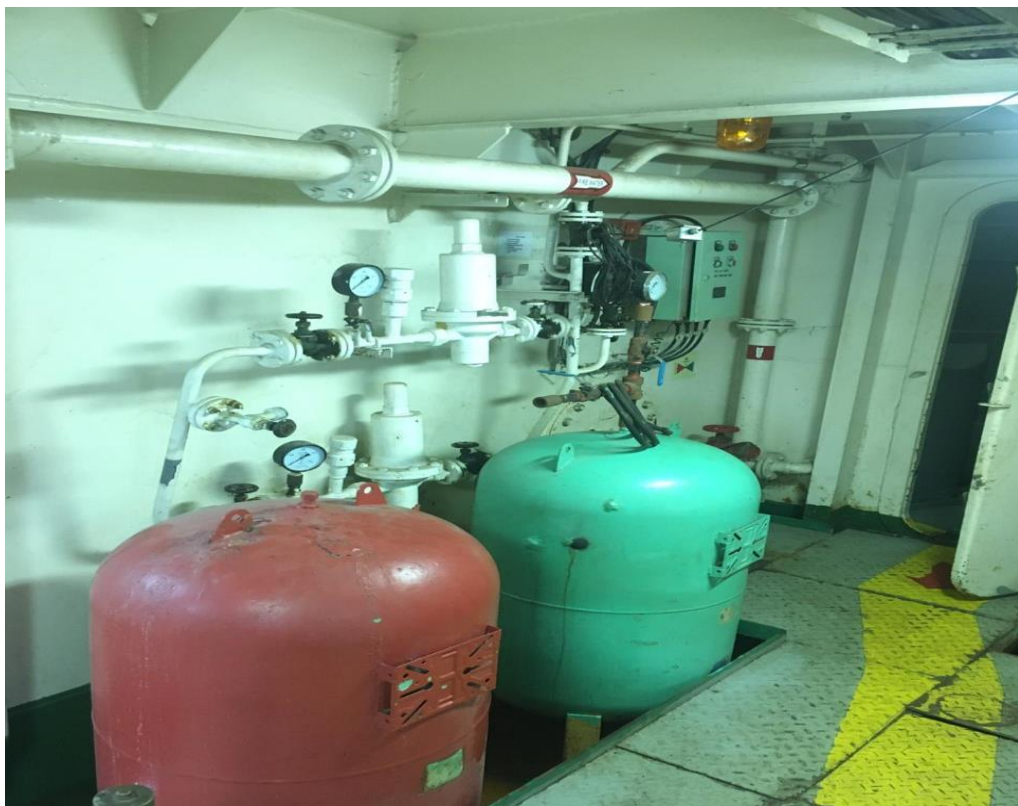
Gambar2.2 Hydrophore tank di AHTS.Etzomer 501.
