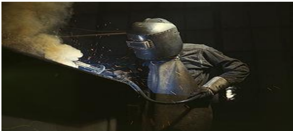
Gambar 11. Welding Perisai Sumber : Dokumen pribadi
