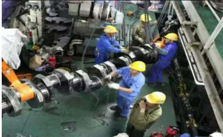
Gambar 2.4 pemasangan crankshaft SV .MINERVA 88
