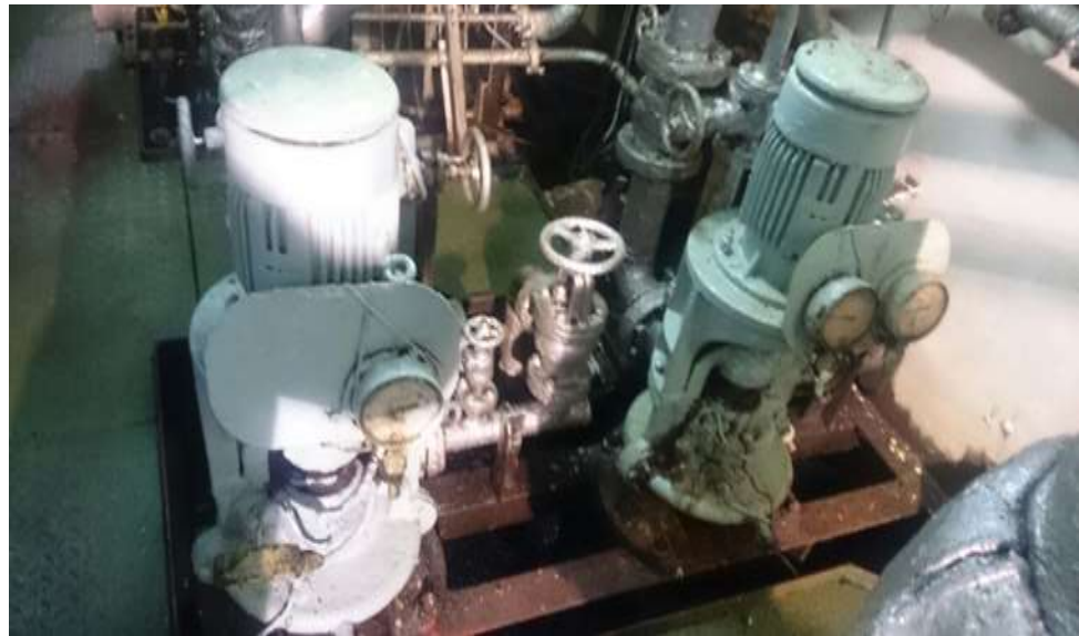
Gambar 2.6 Kondensat pump no.1 & 2 (MT. Pelita P1023)
