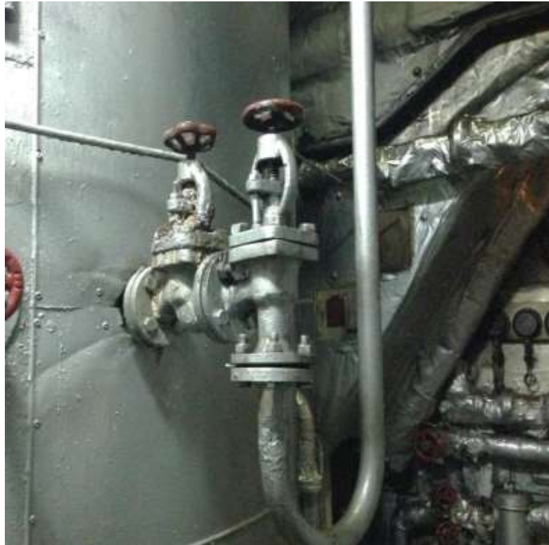
Gambar 2.12. Katub Pengisian Boiler (MV. Sinar Papua)
