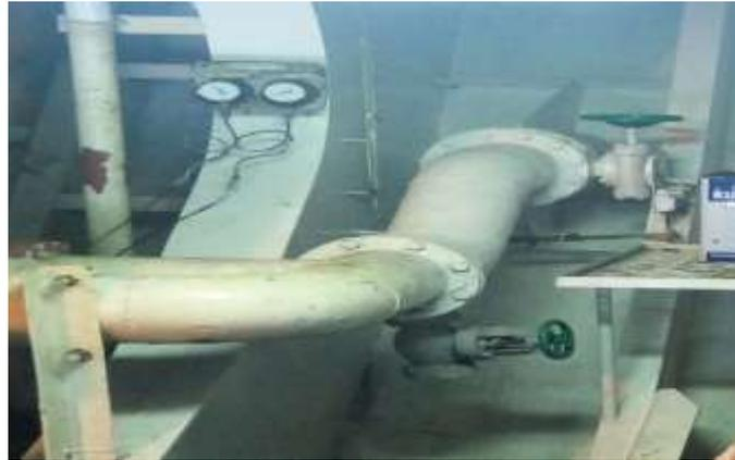
Gambar 7 sistem pipa air laut dikapal
