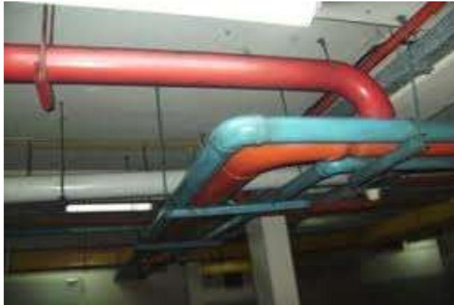
Gambar 3 *elbow* / pipa yang bengkok
