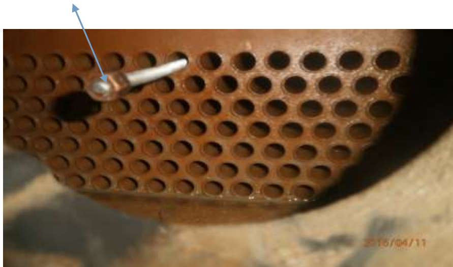
Gambar 8 Perawatan pada kondensor
