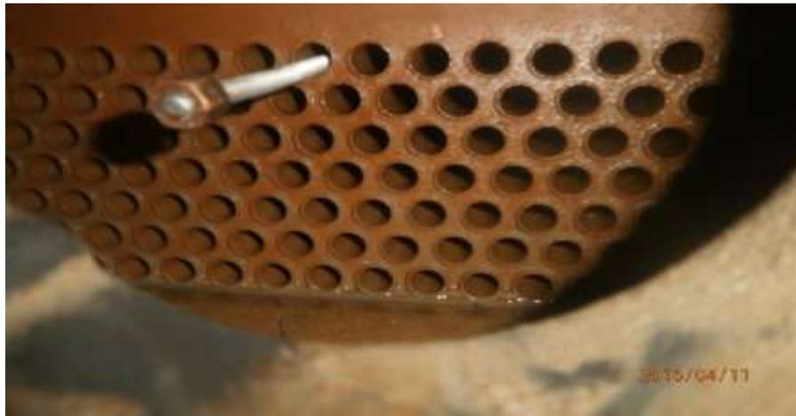
Gambar 5 Perawatan pada kondensor
