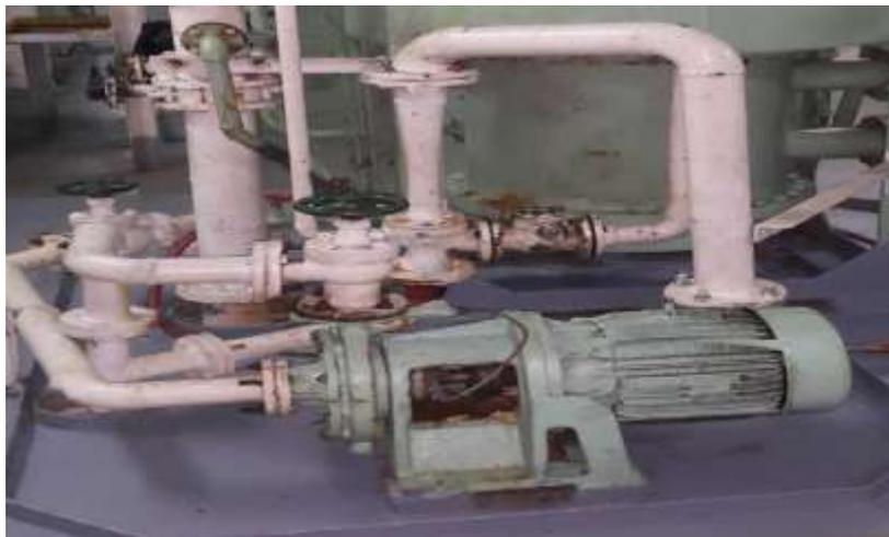
Gambar 6 *Ejector Pump*
