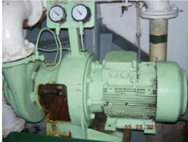
Gambar no.1. pompa ballast jenis centrifugal
