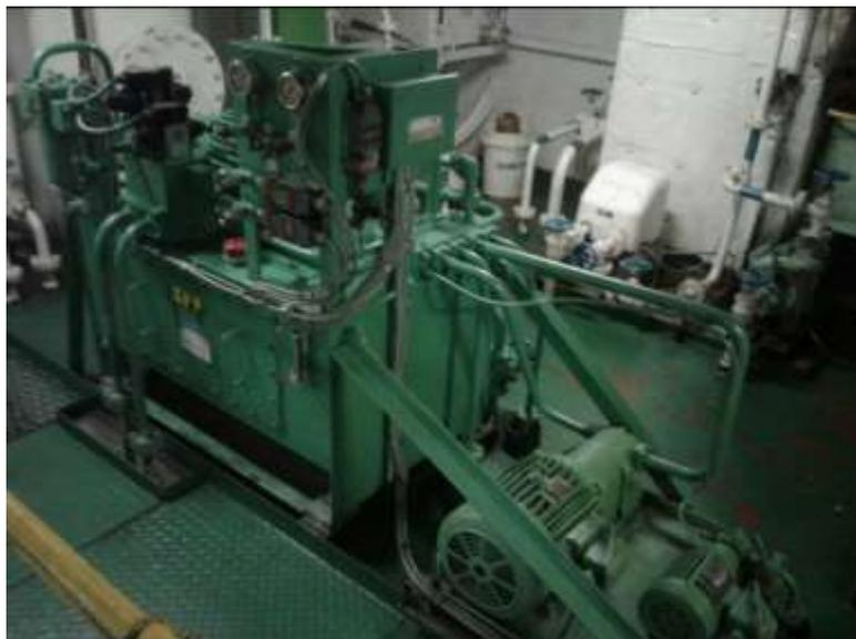
Gambar 2.9 Konstruksi Hydraulic Power Pack
