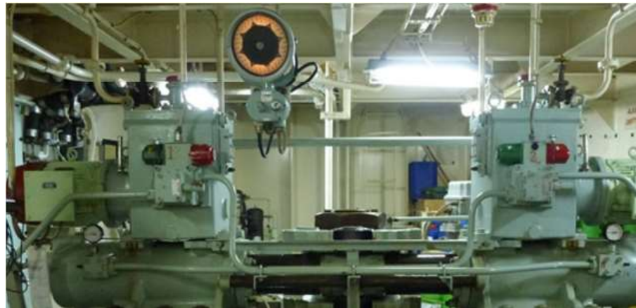
Gambar 11 Emergency Steering Gear (Spada 2018 Sistem Kelistrikan Kapal Niaga, Ristekdikti: Jakarta)
