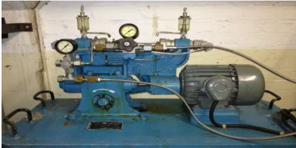
Gambar 9 Electro Motor Pada Booster Pump (Spada 2018 Sistem Kelistrikan Kapal Niaga, Ristekdikti: Jakarta)
