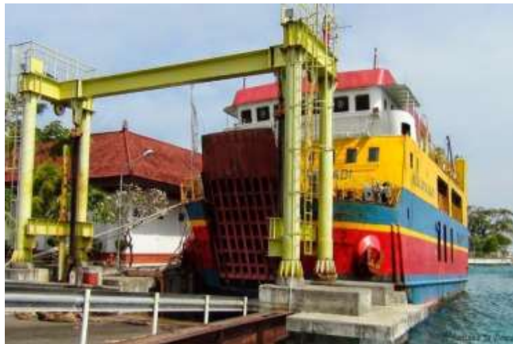
Gambar 5 Pintu Rampa Kapal Nusa jaya abadi
