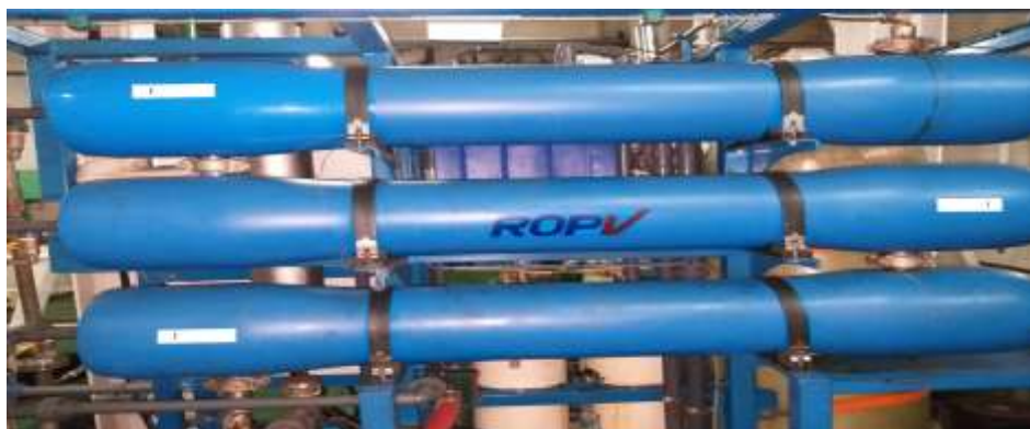
Gambar 2.7 Membran (Sumber : Data Pribadi Penulis)
