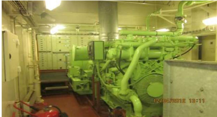
Gambar 1. Kompresor Udara. Sumber: (Dokumen KN. GANDIWA P.118)
