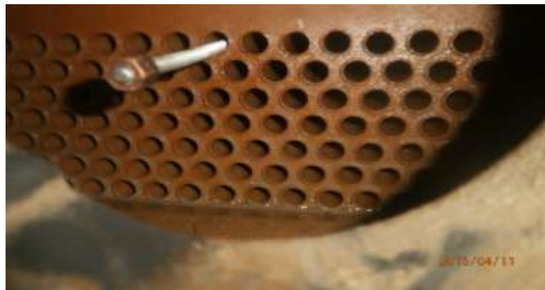
Gambar 5 Perawatan pada kondensor
