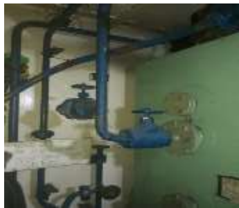
Gambar 11. Kran Pemasukan Air
