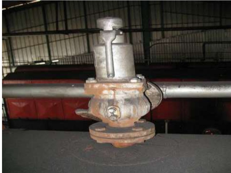
Gambar 14 Keran Uap Induk (Kurniawan Shinobi, 2010 komponen ketel uap, Batang : Jateng)
