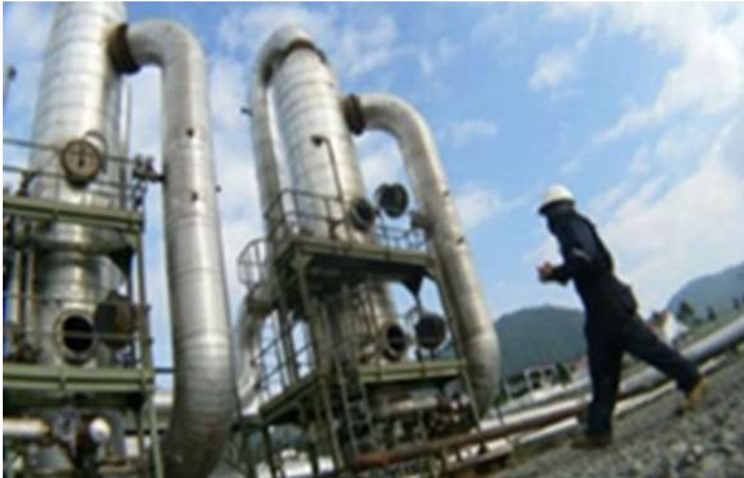
Gambar 1 Ketel Uap (Kuntoro Tayubi, 2017 pembangunan pltu, batang : Jateng)
