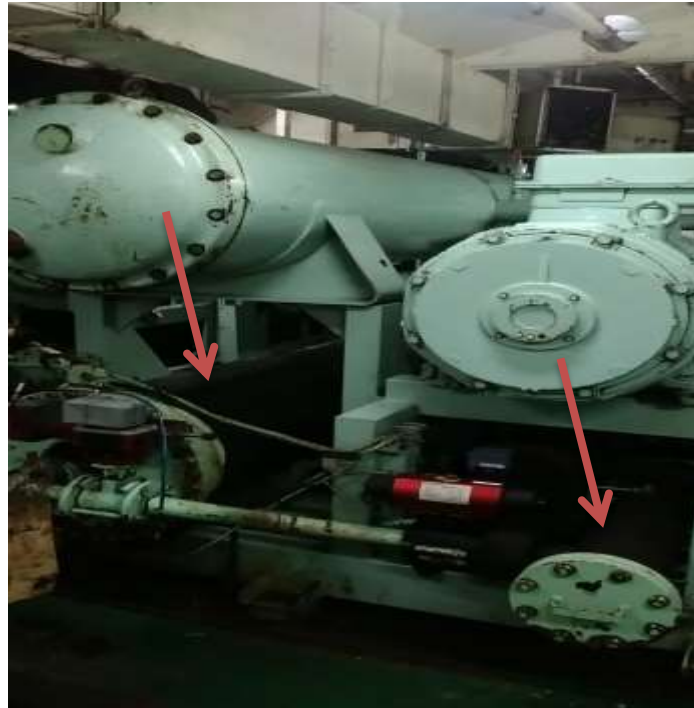
Gambar : 2.4 Evaporator dan Oil Separator
