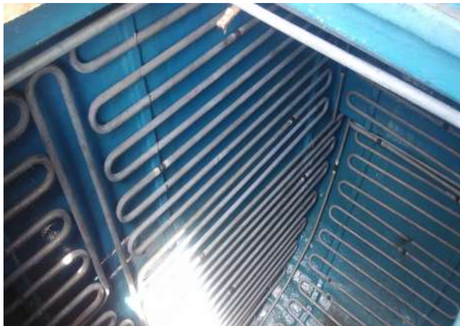
Gambar 11: Penampang Evaporator didalam Palka (sumber : M.Yuni 2018 Palka Kapal Nelayan Utomo Tambah Mulyo – 3 : Juwana)
