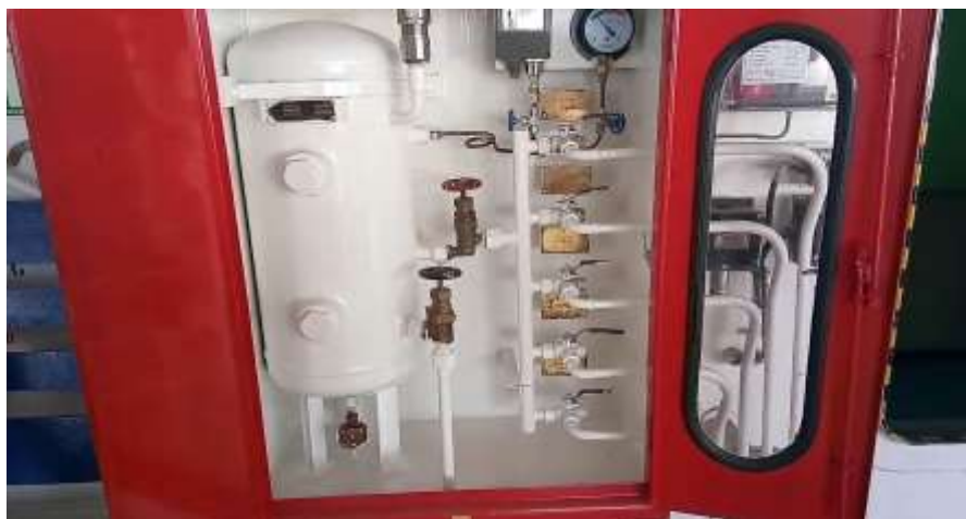
Gambar 2.1 Panel dan air receiver untuk quick closing valve ( Sumber: Dokumentasi penulis )
